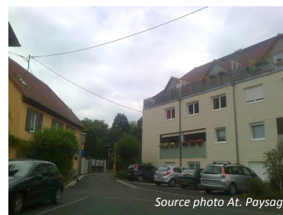
Diversification du bâti à Buhl
