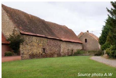
Bâti ancien en pierre et en grès
