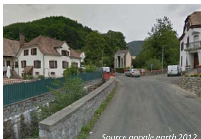
Centre de la commune de Linthal
