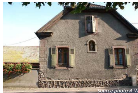
Ancienne Maison d'Ouvrier Agricole
