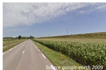
La digue le long du Grand Canal
