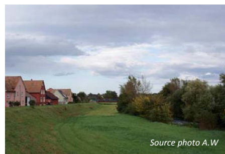
La digue le long de l'Ill qui protège le bâti
