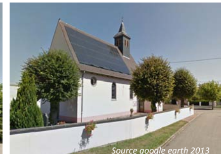
L'église Saint-Wendelin à Roggenhouse
