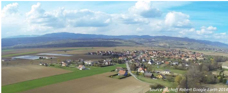
Gundolsheim – Vue aérienne des extensions urbaines le long des voies
