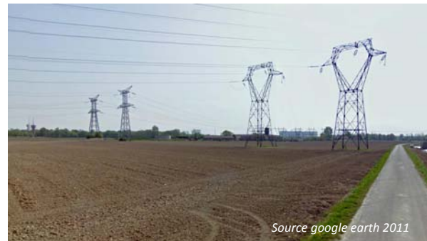
L'impact visuel des lignes haute-tension et pylône dans la Plaine
